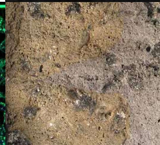
Chloridindtrængningen - indikeret af det lyse område - er forøget omkring det kolde støbeskel. Ses som en "tunge" ind fra toppen ca. midt i betonprøven
