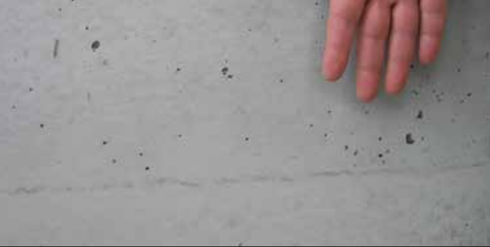
Det varme støbeskel kan anes på betonens overflade med det blotte øje
