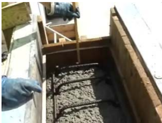
Figur 2-4: Fyldning af vægform under 3. prøvestøbning 08-08-2006. Bemærk tydeligt tilslag i overfladen.
