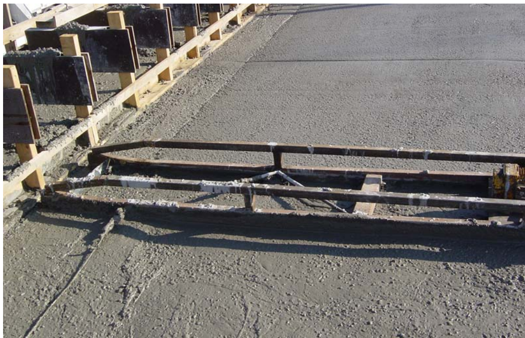
Figur 3-8: Øverst: Forrest foregår fyldning af beton og grovafretning. Bagved manden med skovlen ses vibratorbjælken, som definerer brodækkets tværfald. Derefter ses en arbejdsplatform som benyttes til pudsearbejdet Nederst ses vibratorbjælken og detaljen omkring dybdelinien.
