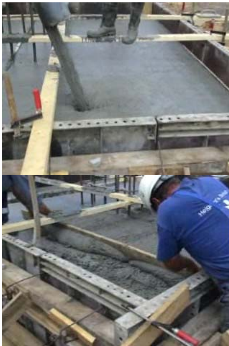
Figur 3-1: Øverst: Fyldning af fundament for endevederlag vha. båndudlægning. Fra båndet styres betonen de 3 m ned i formen via en ståltragt og stålrør.
