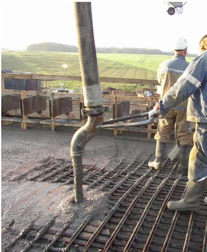
Figur 3-9: Fyldning af beton i tværsnittets centrale del. Øverst til højre ses den trillebør, som blev anvendt til at fragte betonprøver fra pumpen til kontrollanterne på jorden.
