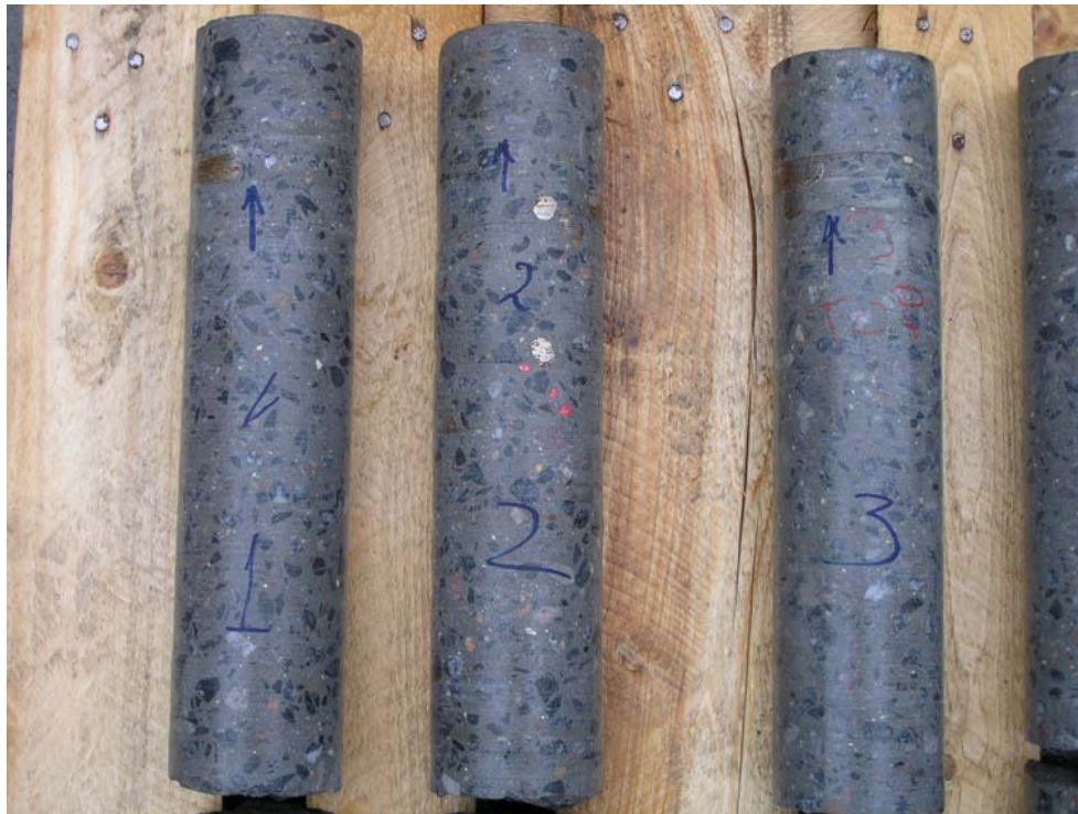
Figur 2-7: Borekerner 1-3 med synlig armering. Der ses ingen tegn på separation.
