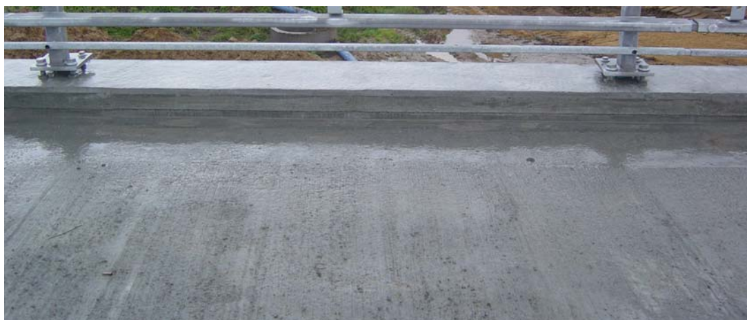
Figur 3-12: Færdig overside med kantbjælkeopspring og kostet overflade.
