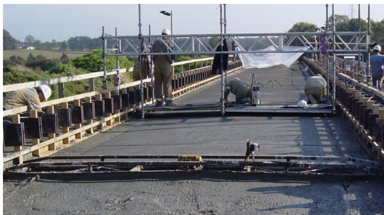
Figur 3-11: Afdækning med plastik foregår bagerst i billedet.
