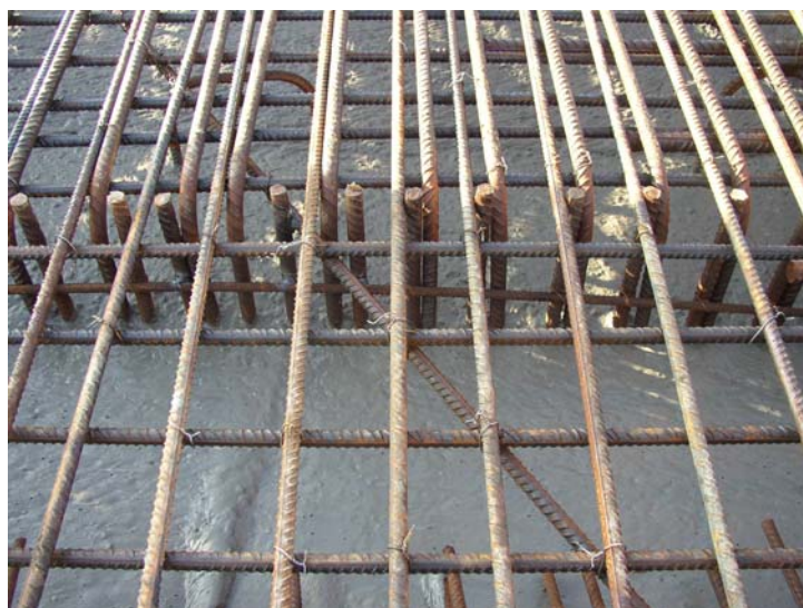
Figur 3-7: Foto taget på tværs af broen ved skrå støbefront. Brotværsnittet er fyldt over halvvejs op.
