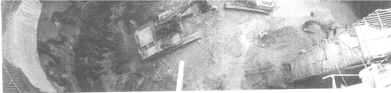
FJERNVARMETUNNELEN, hvor der er benyttet stålfiberbeton, begynder på Amagerværket og slutter på Nørrebro i København. Foto: Polfoto
