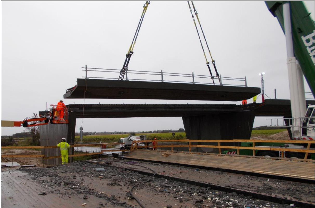
Foto 4: Montage af brodækelement med mobilkran. Foto taget af Rolf Skovlække, MT Højgaard.
