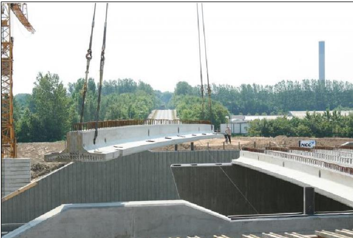
Foto 2: Elementmonteret bro, hvor ende- og midterunderstøtninger består af in situ-støbt beton og brodækket af fabriksproducerede elementer, som løftes på plads med kran.
