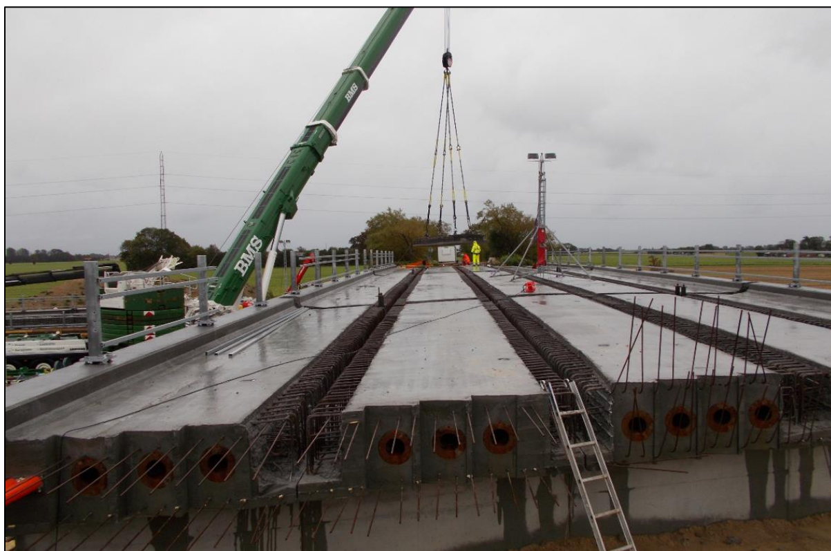
Foto 5: Brodæk støbes i fuld højde og sammenstøbes med kantbjælke, men der skal stadig udføres en del sammenstøbninger både på tværs og på langs af brodækket. Foto taget af Rolf Skovlørke, MT Højgaard.
