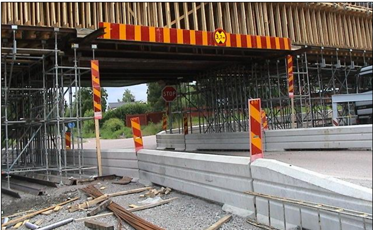
Foto 1: Eksempel på brodæk som in situ-støbes over vej i drift, og hvor der er etableret gennemkørselsåbning i støbestilladset.
