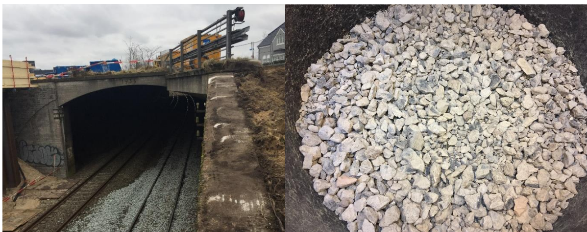
Figur 2. Banebro (til venstre) og 4/22 mm fraktion af den nedknuste beton fra banebro til (højre).
