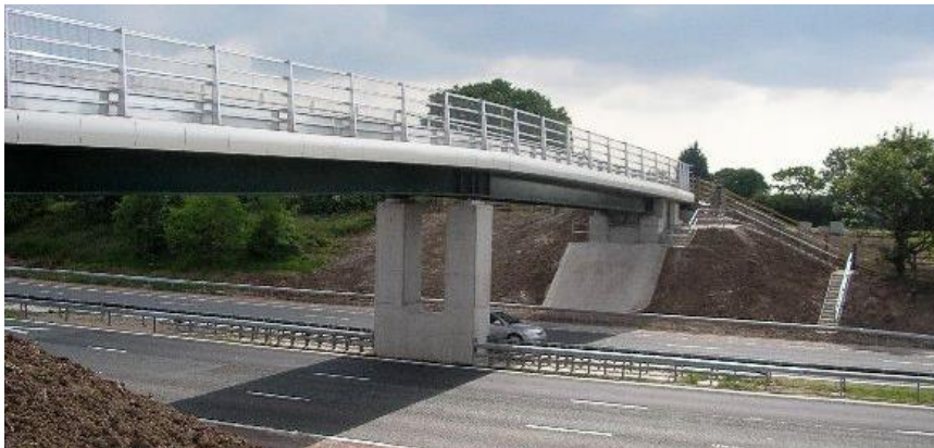
Figur 2.3-5 Moderne hybrid-konstruktion over M6 motorvejen ved Lancashire.
