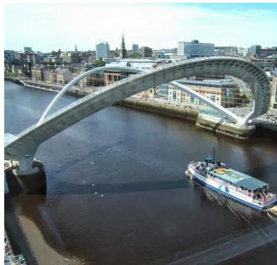
Figur 2.1-5 Gateshead Millenium Bridge: Tv: "Lukket bro" med adgang for cyklister og fodgængere. Th: "Åben bro" med øget frihøjde til den sejlen- de trafik under broen.
