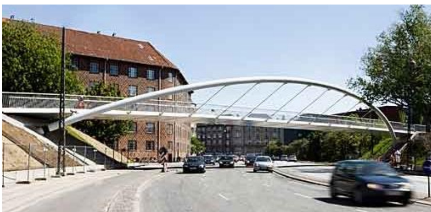
Figur 2.1-1 Ågade Stibro – slank konstruktion i stål.
