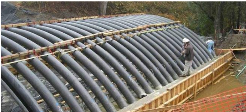
Figur 2.4-1 Kulfiberslanger placeres på fundamenter.
