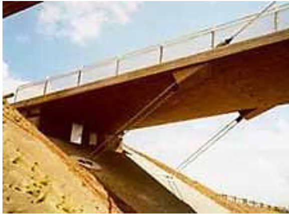
Figur 2.4-4 Skråtagsbro ved Herning med armering og kabelstag i kulfiber.
