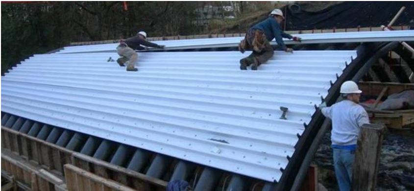
Figur 2.4-2 Skal af korrugeret plast lægges oven på rørene.
