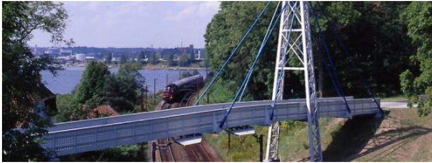
Figur 2.3-1 Stibro ved Kolding udført i plastbaseret komposit fra danske Fiberline.
